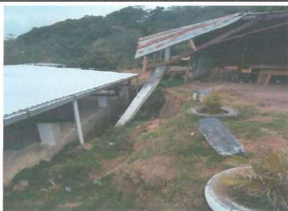
Mejoramiento de muro perimetral.
