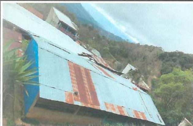
Mejoramiento de estructura y techado de lámina troquelada calibre 26.
